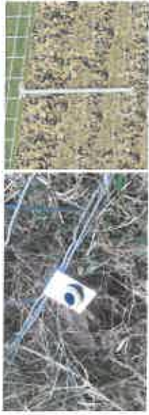
Mise en place d'un grillage par-dessus le gîte avec fixation au sol @eurobomes.com
